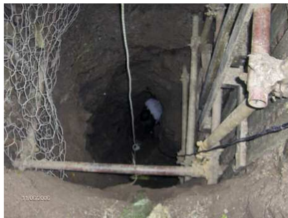
Fig. 1 – Il pozzo artificiale in corso di scavo.
