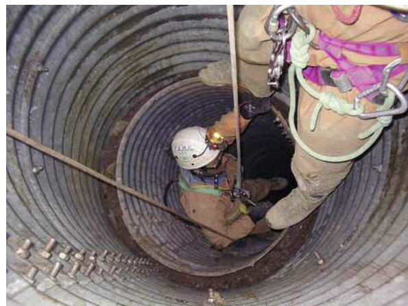
Fig. 3 - Il pozzo artificiale dopo la messa in sicurezza.
