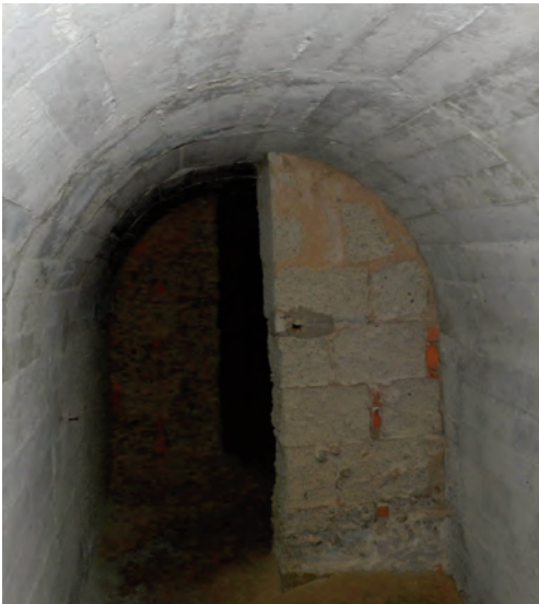
Sopra - Muri antisoffio.
